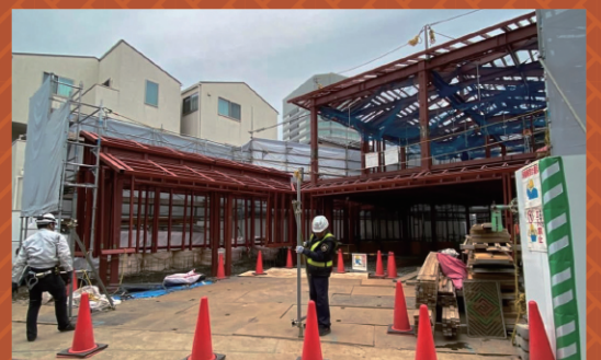
建設現場の様子
