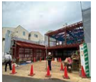
建設現場の様子
